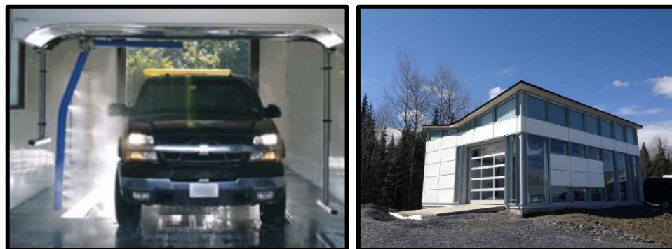
Figure 19. Lave-autos automatiques stationnaires
