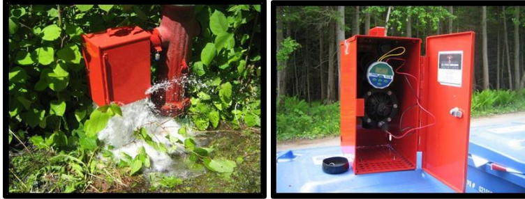
Figure 24. Purges programmables sur poteau d'incendie
