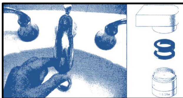
Figure 17. Les nouveaux robinets sont munis d'aérateurs faciles à enlever et à nettoyer (le débit est ainsi réduit à moins de 5,7 l/min)
